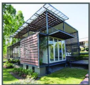
การติดตั้ง
