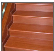
การติดตั้ง
