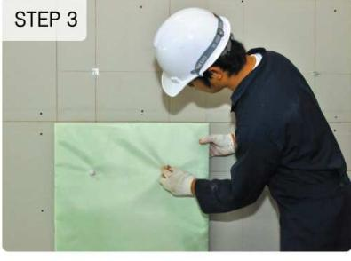
ติด Spindle Pin ตามระยะทางที่กำหนดไว้แล้วจนครบทุกจุด และทิ้งไว้ให้การแห้งเพื่อรับน้ำหนักได้เต็มที่
