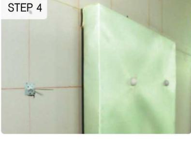
ติดตั้ง วัสดุอะคูสติก เอสซีจี สำหรับผนังดูดซับเสียง Cylence Zoftone™ กับ Spindle Pin โดยเลียบให้严密 โดยมีรูปแบบการของก้าวติดตั้งหัวหมุดทั้งสิ้น 2 แบบ
