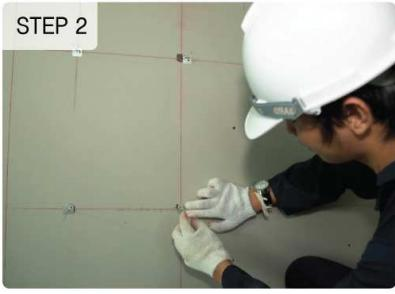
ทำการติดตั้ง Spindle Pin ด้วยการชนิดพิเศษ ในกรณีที่เป็นผนังปูนซิ่ม หรือผนังไม้สามารถยึดด้วยวิธีตอกตะปุ่นได้
