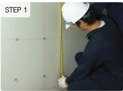
กำหนดตำแหน่งที่จะติดตั้ง Spindle Pin ให้มีระยะห่างหมุดประมาณ 30-45 ซม. ในกรณีที่เป็นผนังคอนกรีตที่มีการทาสีไปแล้ว ให้ทำการลอกออกในตำแหน่งที่จะติด Spindle Pin
