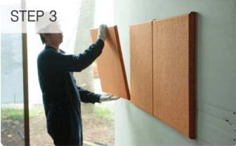
นำแผ่นวัสดุอะคริลิก เอสซีจี สำหรับผนังตกแต่งคุณภาพเสียง รุ่น Cylence™ Zandera™ ที่ทำการมาติดตั้งเข้ากับผนังที่เตรียมไว้ โดยกดทึบไว้ประมาณ 1-3 นาที ให้การเข้าตัวดีติดกับผนังจนแน่น ควรเริ่มติดตั้งจากตรงกลางของแผ่นด้านล่างขึ้นไปด้านบน
