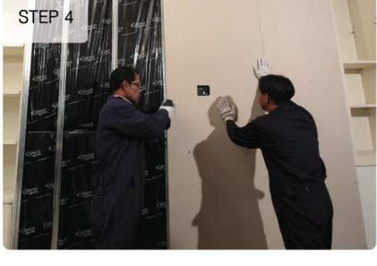
ติดตั้งโครงคร่าวโลหะสำหรับผนังเบา C64 / U66 หรือ โครงคร่าวโลหะ C74, U76 โดยวิธี ระยะห่าง 0.60 ม. หรือ 0.40 ม. และปิดด้านหนึ่งด้วยแผ่นสมาร์ทบอร์ด เอสซีจี ด้านหนึ่ง
