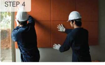
ติดตั้งแผ่นวัสดุอะคริลิก เอสซีจี สำหรับผนังตกแต่งคุณภาพเสียง รุ่น Cylence™ Zandera™ จะเต็มพื้นที่ที่ต้องการ และตรวจสอบความเรียบร้อย พร้อมเก็บรายละเอียดของงาน
