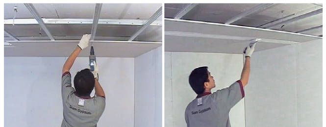
6 ติดแผ่นยิปซัมตราช้าง ขอบลาด เข้ากับโครงแนวนอน ด้วยสกรูยิปซัม ขนาด 25 มม. โดยสกรูทุกกระยะ: 20 ซม. ที่บริเวณขอบแผ่น และ 30 ซม. ที่บริเวณกลางแผ่น
