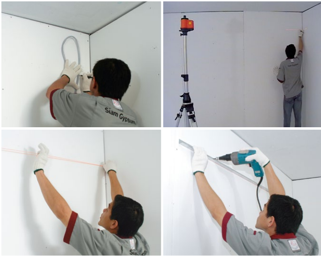
1 กำหนดระดับฝ้ารอบห้อง แล้วติดตั้งโครงรับโปร ตามระดับ
