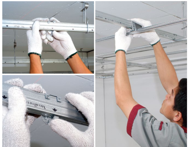
5 ล็อกโครงโปร ซิลาไนน์ แนวนอนเข้าด้านล่างโครงแนวตั้งด้วยคลิปล็อกโปร ให้โครงนอนแต่ละแถวห่างกัน 40 ซม. แล้วเช็คระดับอีกครั้งด้วยเอ็น และระดับน้ำหรือเลเซอร์ (โดยที่คลิปล็อกควรหันสลับด้านกัน)
