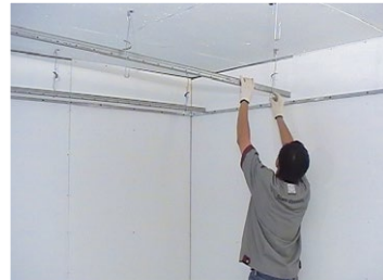
4 ล็อกโครงโปร ซิลาไนน์ แนวตั้งเข้ากับขอบของชุดปรับระดับที่หันสลับด้านกัน เมื่อต้องต่อโครง ให้ใช้ตัวต่อพิเศษ หรือ ตัวต่อแบบ เอช โดยไม่ใหรรอยต่อของโครงแถวติดกันอยู่ตรงกัน แล้วปรับระดับให้ถูกต้องอย่างละเอียดอีกครั้ง (โดยที่โครงหลักตัวแรกสุดอยู่ห่างจากผนังไม่เกิน 15 ซม.)
